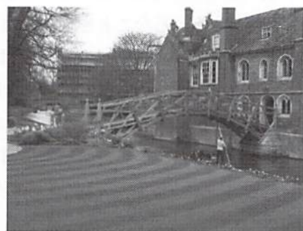
ケンブリッジ大学の Mathematical Bridge。橋 は円の接線でできている
