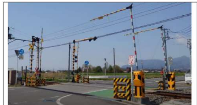
奥側:電線に引っかからないようにするための屈折式遮断桿
