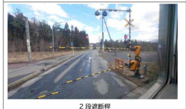
奥側:電線に引っかからないようにするための屈折式遮断桿
