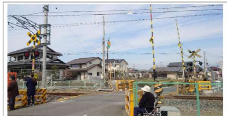
奥側:それぞれの道の方向に向かって設置されている(1つの警報機柱に6つ警報灯が設置されている。 手前:(手前にのびている道路と、右に向かって続く道がある)全方位式警報灯でどの方向からも見えるようになっている
